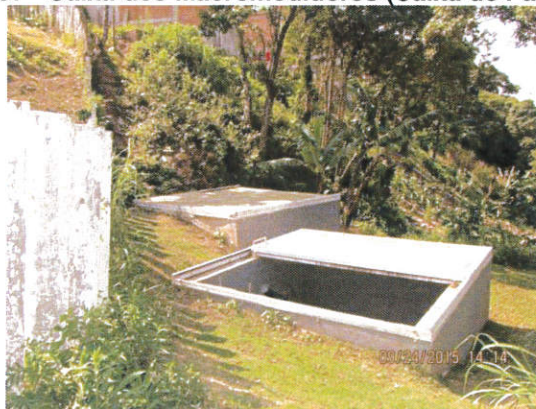
Figura 57 - Caixa dos Macromedidores (Caixa de Passagem)
