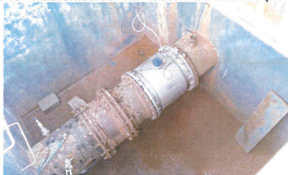
Figura 49 - Macromedidor na Adutora de Entrada (Alto Tietê)
