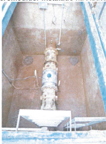
Figura 51 - Macromedidor Instalado na Adutora de Ø300 mm
