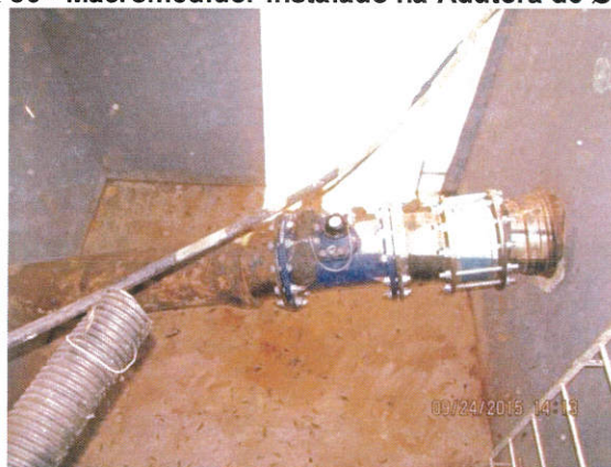
Figura 56 - Macromedidor instalado na Adutora de Ø600 mm
