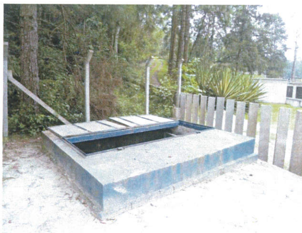
Figura 53 - Caixa do Macromedidor da Adutora de Ø600 mm (E.E. Capiburgo/Caixa de Passagem)
