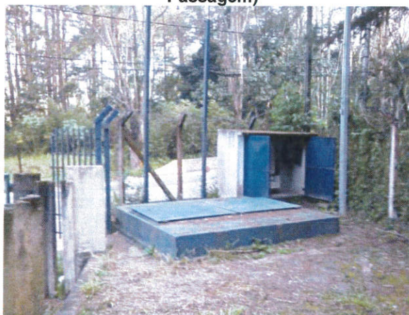
Figura 54 - Caixa do macromedidor da Adutora de 300 mm (E.E. Capiburgo/Caixa de Passagem)
