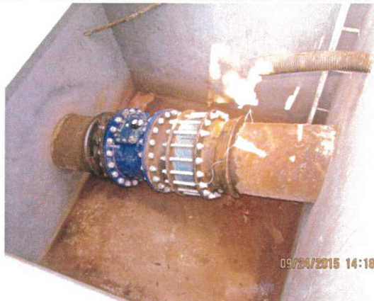
Figura 55 - Macromedidor Instalado na Adutora de Ø300 mm
