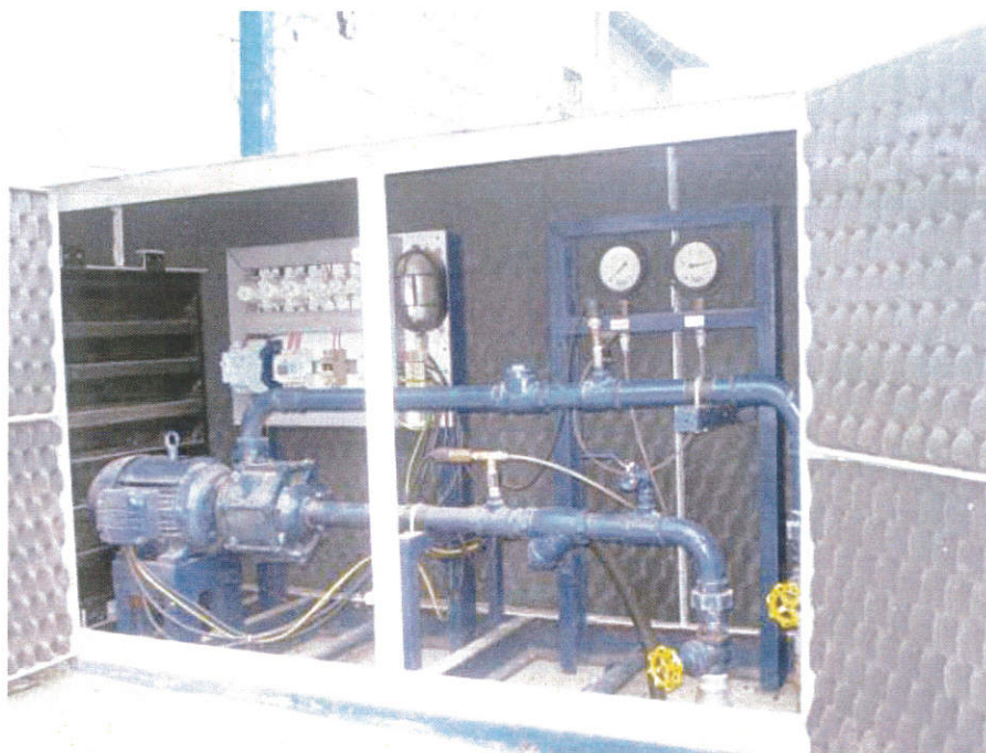
Figura 45 - Modelo de Booster (Conjunto Moto-bomba)
