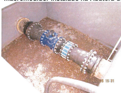
Figura 58 - macromedidor Instalado na Adutora de Ø500 mm
