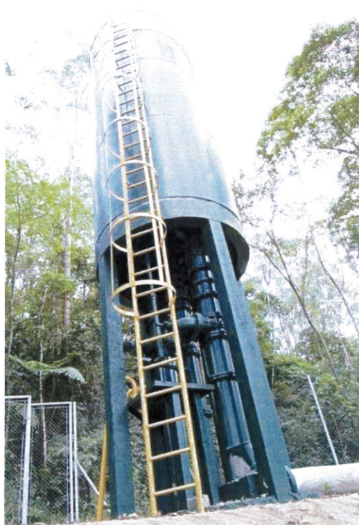
Figura 30 - Tanque de Amortecimento Unidirecional
